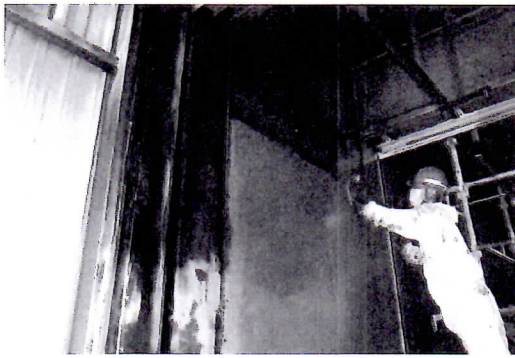
写真-5 壁面のヤニ除去
